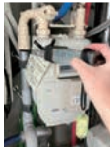
検知器での漏洩検査の様子
