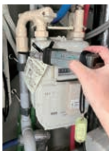
検知器での漏洩検査の様子
